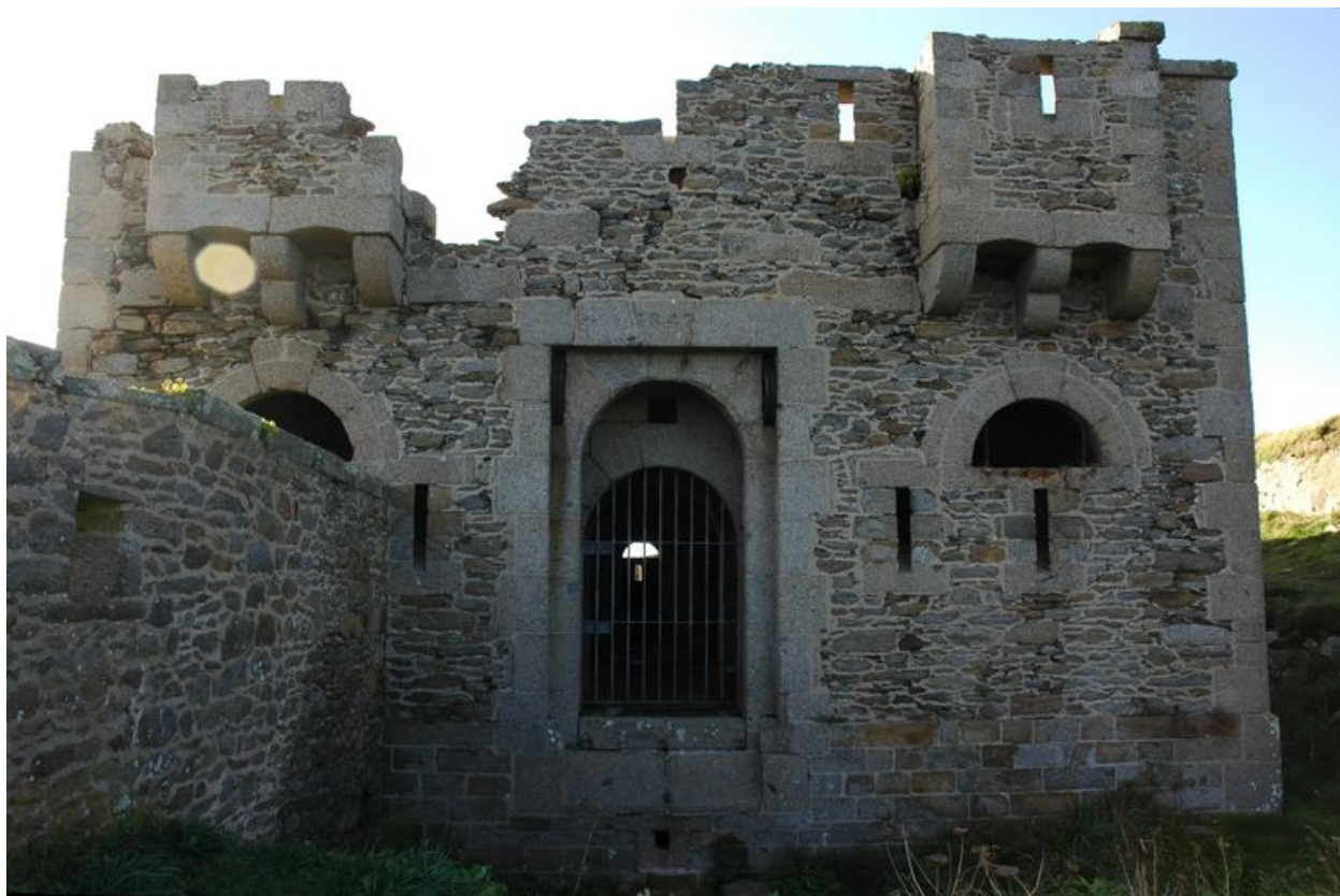
Vue du réduit de l'Îlette : élévation Est
