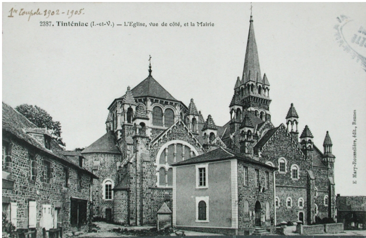
Vue générale au début du 20e siècle
