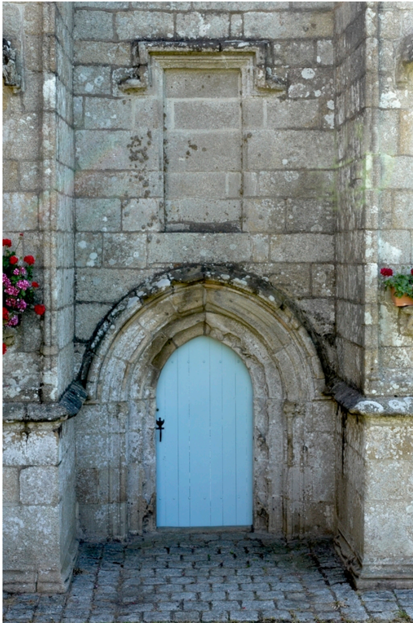
Vue de la porte du bras sud.
