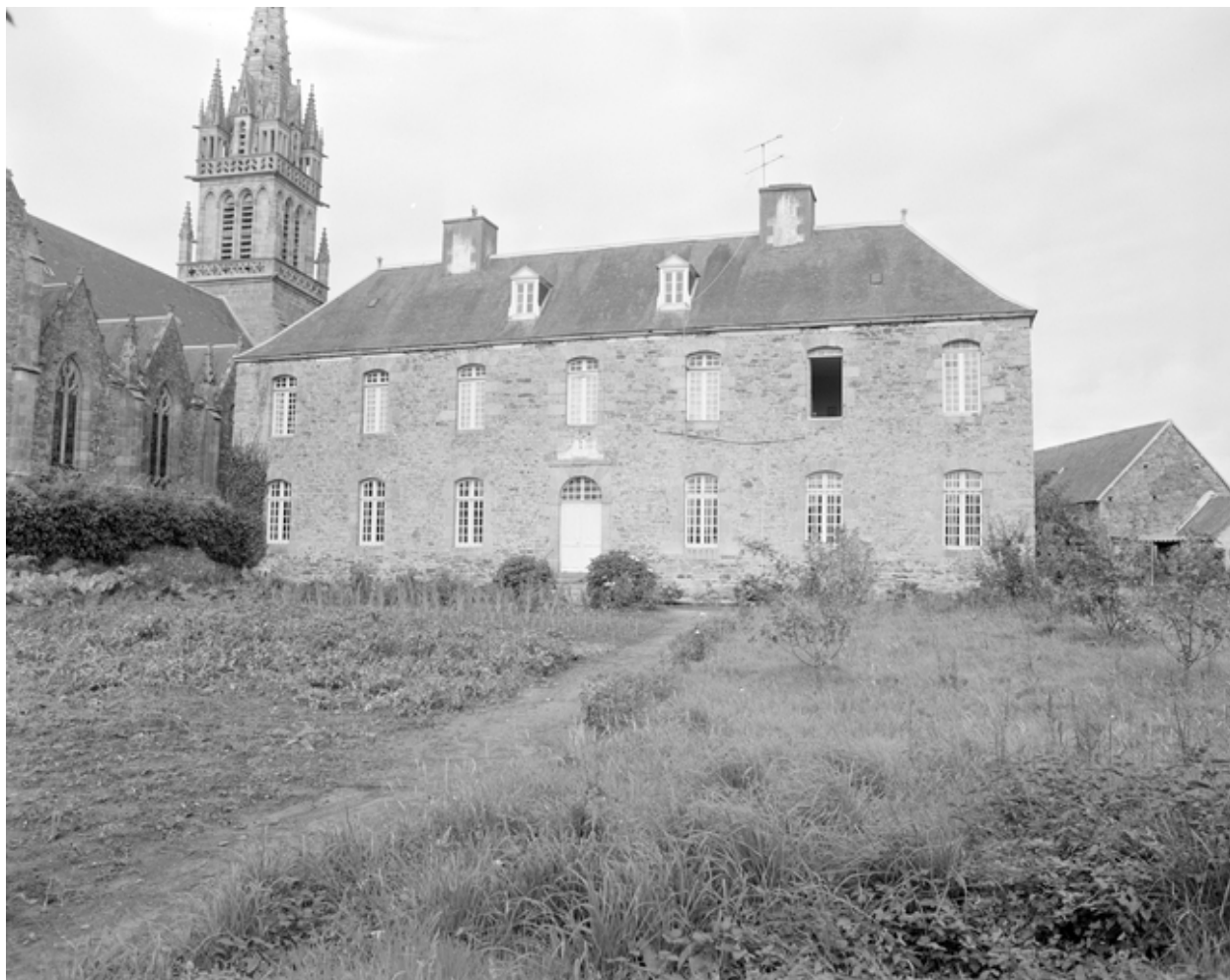
Façade est : vue générale
