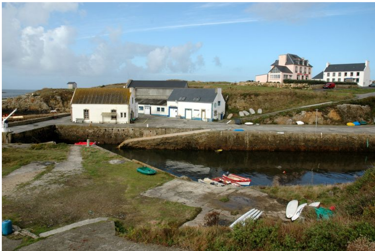
Vue du port-abri de Lampaul
