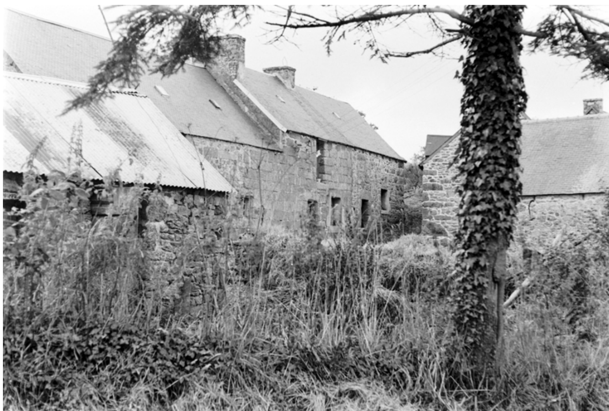
Vue générale de la face sud du corps du logis
