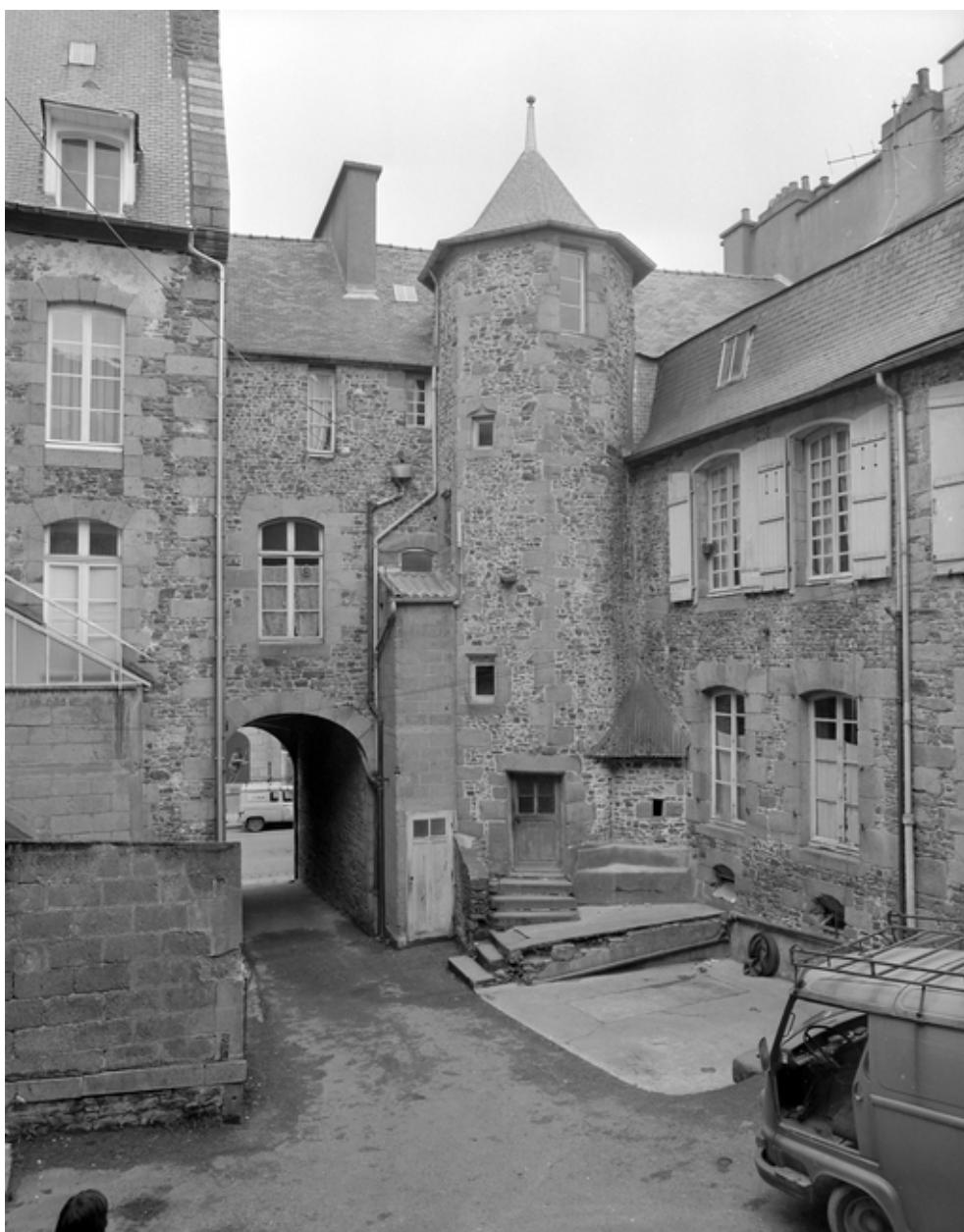
Escalier du corps latéral gauche, vue générale.
