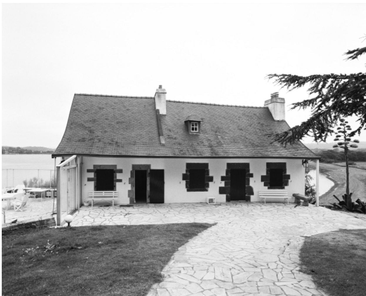
Vue de la maison du gardien et corps de garde : élévation ouest (état en 1996)
