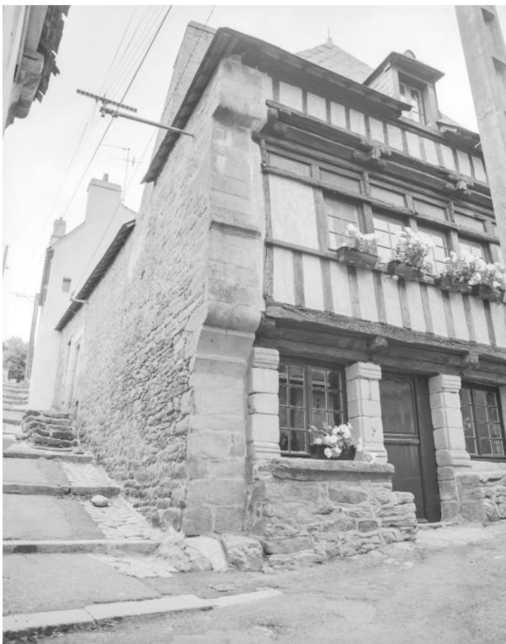
Elévation latérale rue Saint-René, élévation principale rue Saint-Sauveur, vue prise de l'ouest
