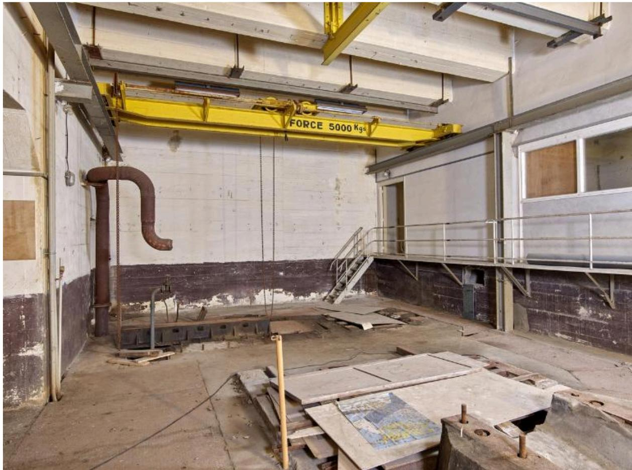
Locaux techniques, partie sud, rez-de-chaussée, grande pièce de la centrale électrique : pont roulant manuel d'une capacité de 5 tonnes. A droite, en entresol, pièces vitrées accessibles par une galerie. A gauche, tuyau et berceau pour moteur
