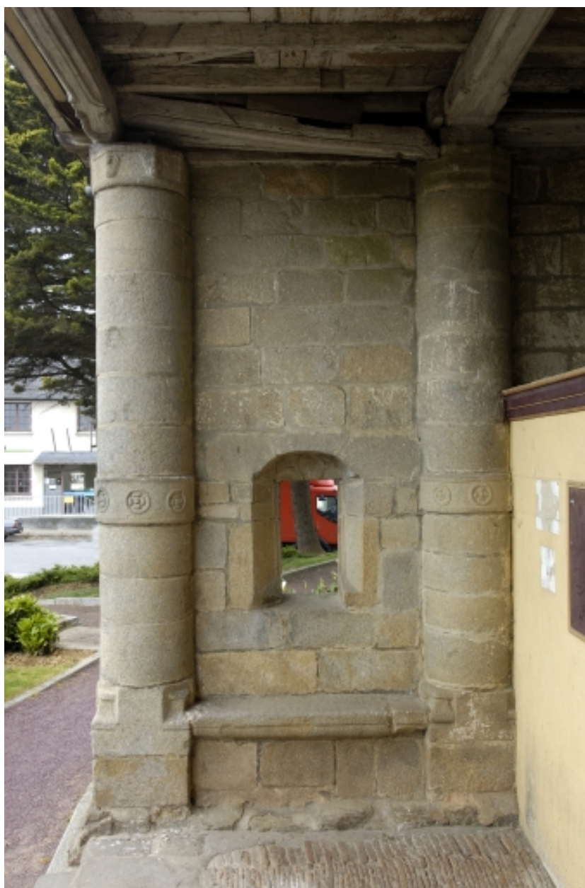
Porche sud ; mur ouest
