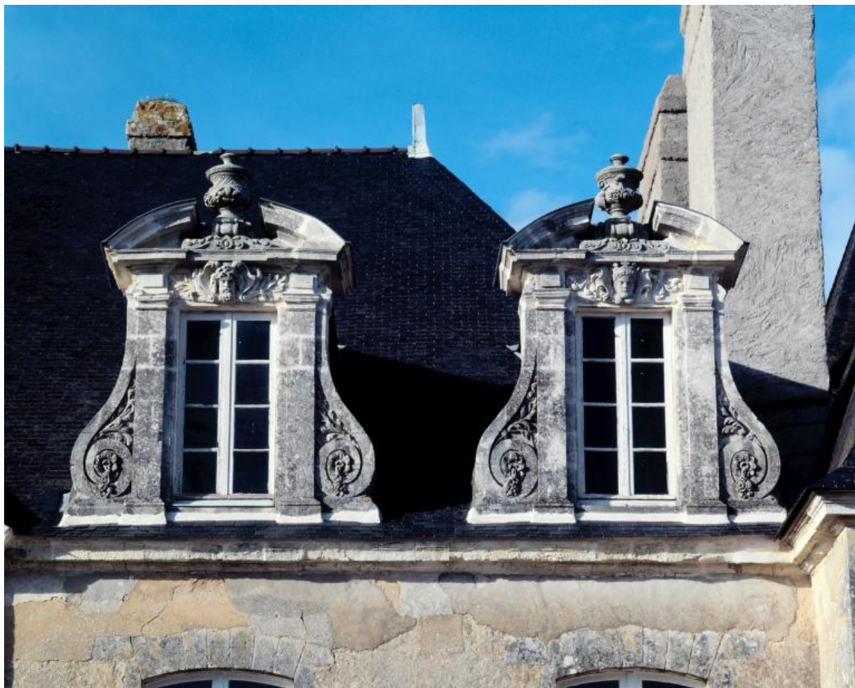
Château, corps principal. Elévation sud, lucarnes.
