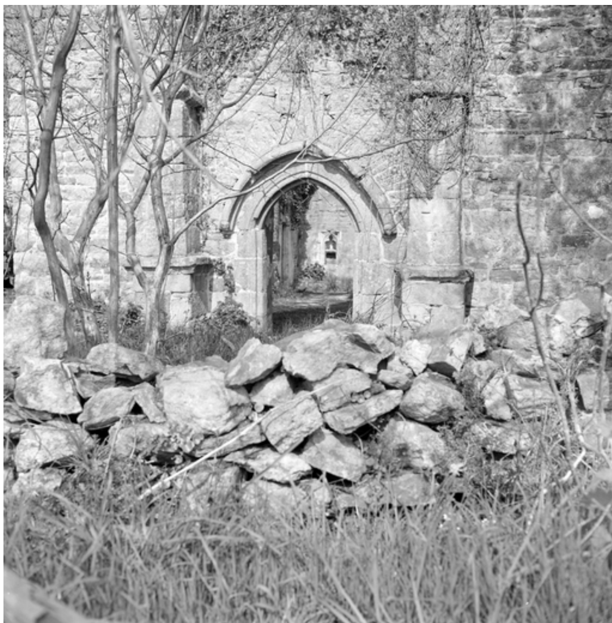
Elévation Ouest, détail : porte (état en 1974).
