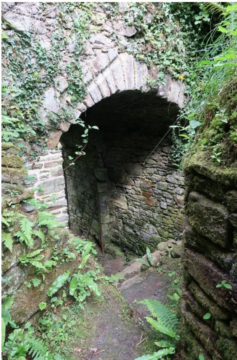
Vue de la porterie ouest : débouché de l'escalier
