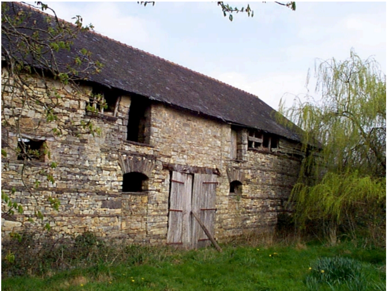
Les communs : vue générale sud-ouest
