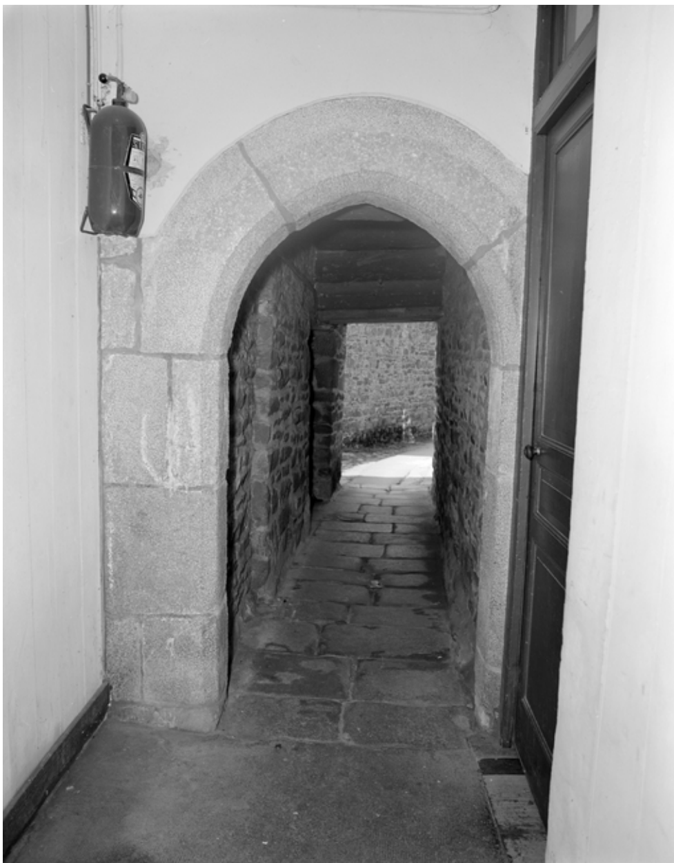
Couloir du rez-de-chaussée
