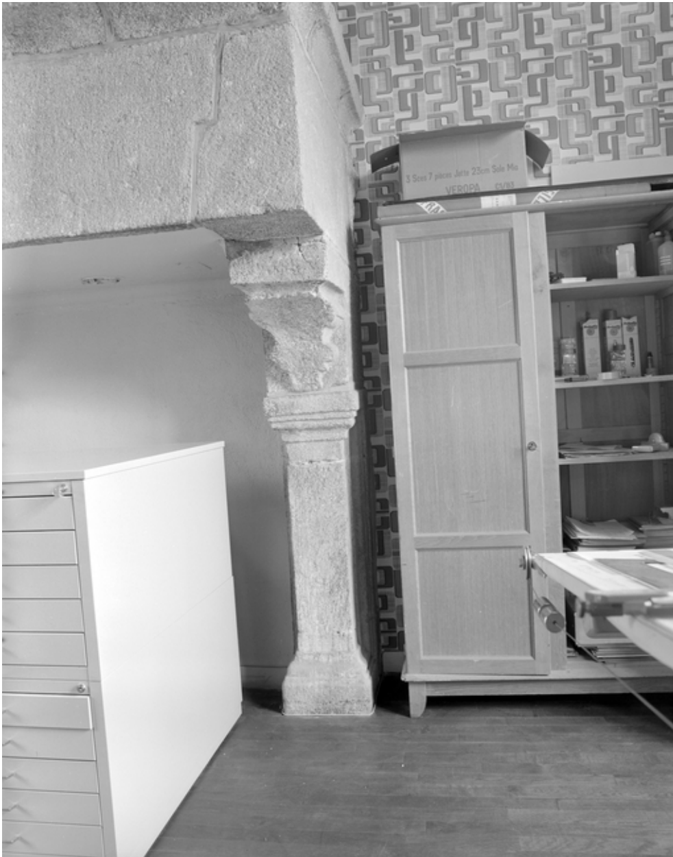
Vue de détail du piedroit de la cheminée du premier étage.
