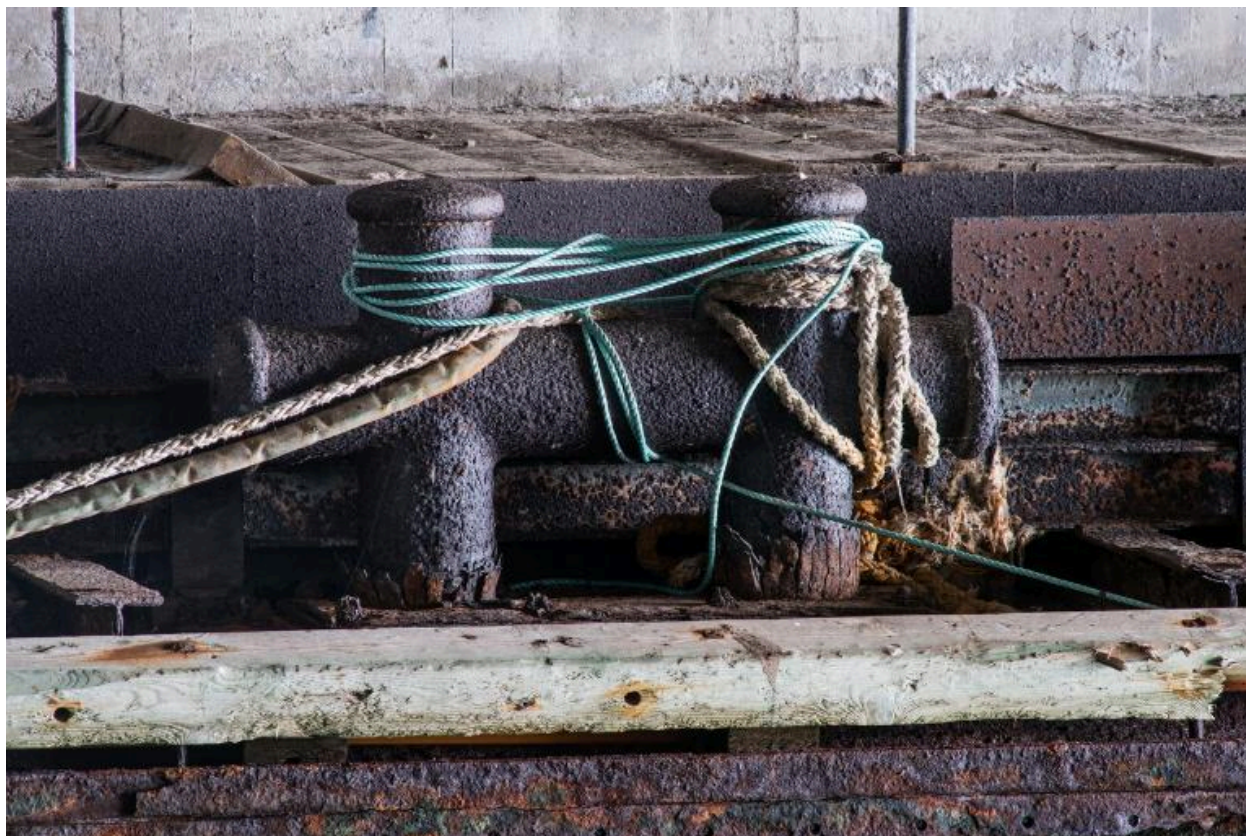
Vue du taquet d'un poste d'amarrage flottant
