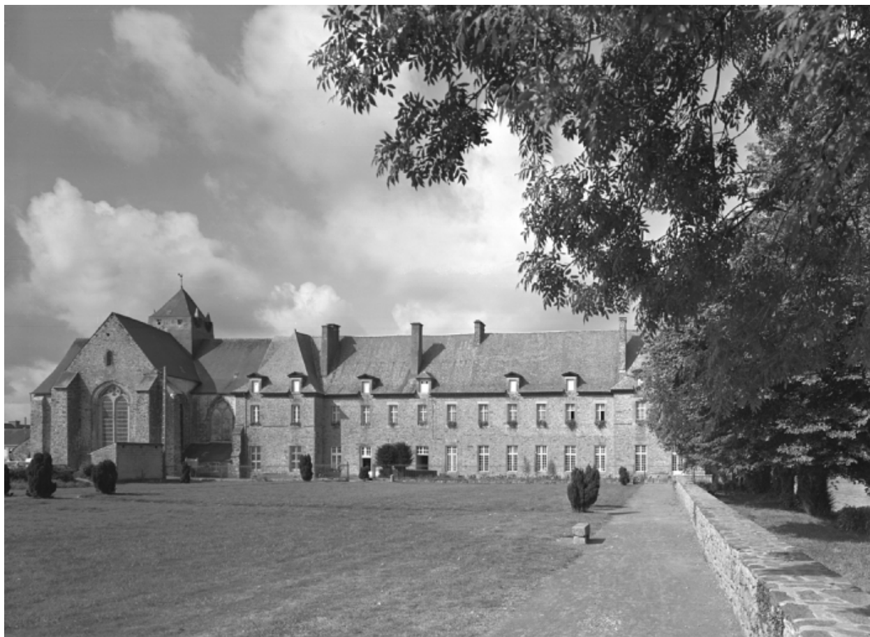
Vue générale prise vers l'ouest
