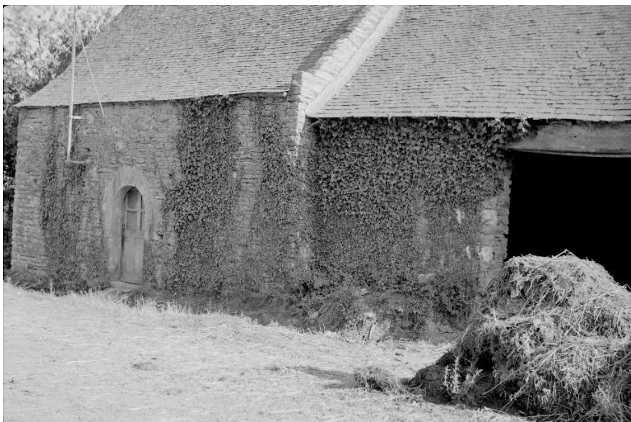
Ferme 56 (état en 1969)
