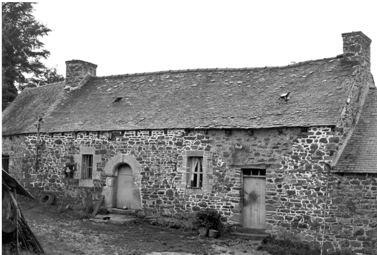
Maisons (Guerseluden) : vue générale
