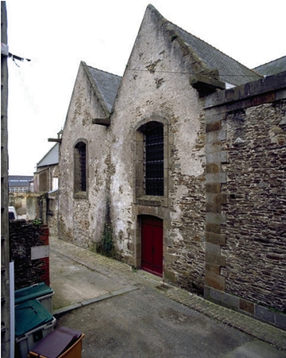
Vue latérale nord
