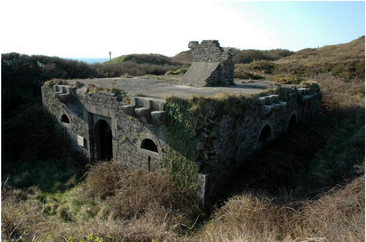
Vue générale depuis le sud-est (état en 2006)
