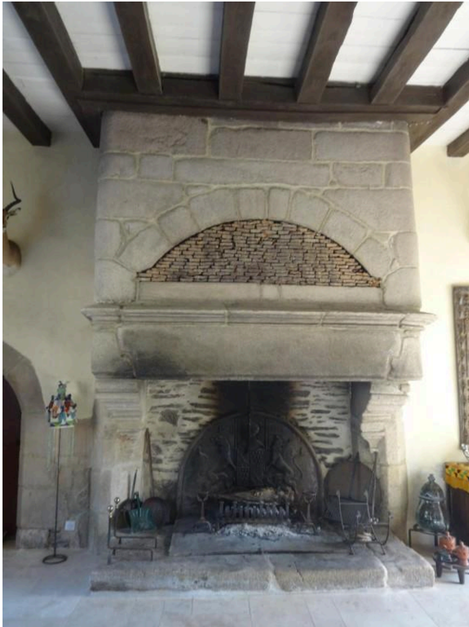
Cheminée de la grande salle (partie basse), détail
