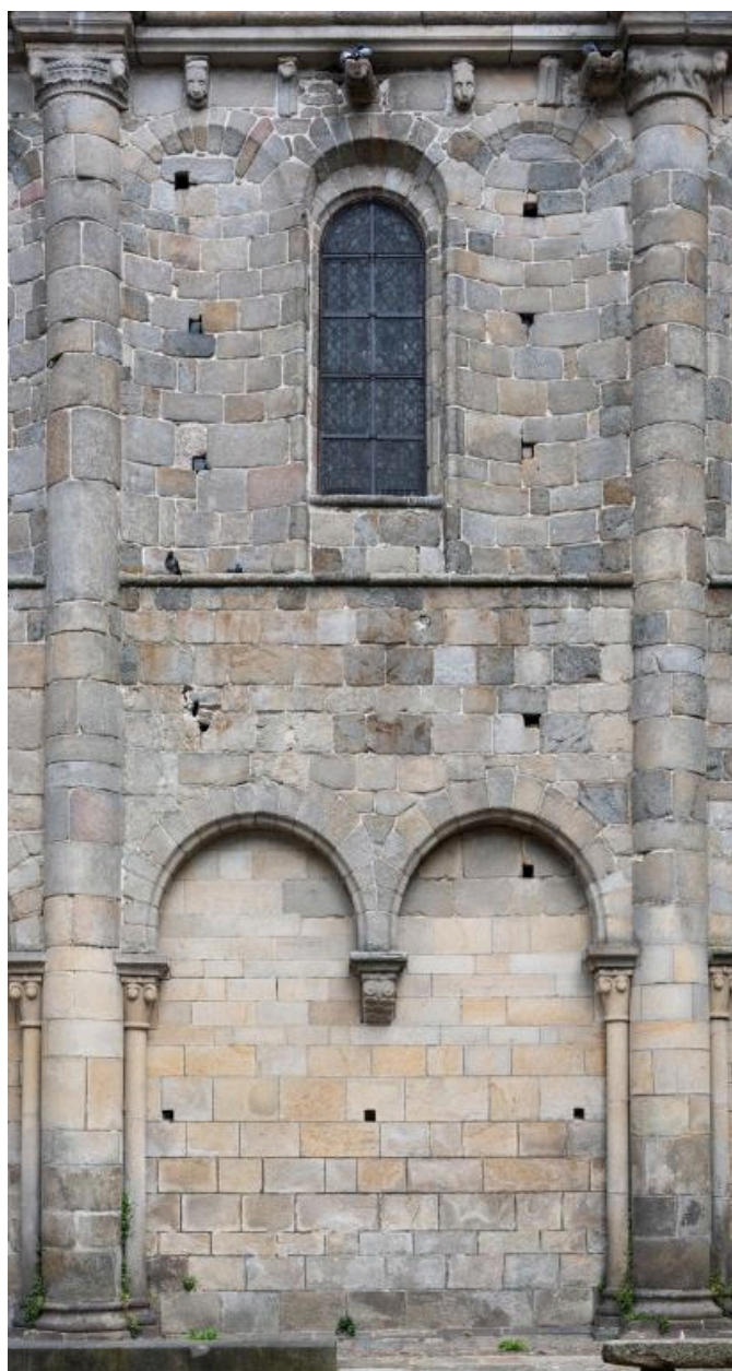
Vue d'une travée du mur sud de la nef en 2019
