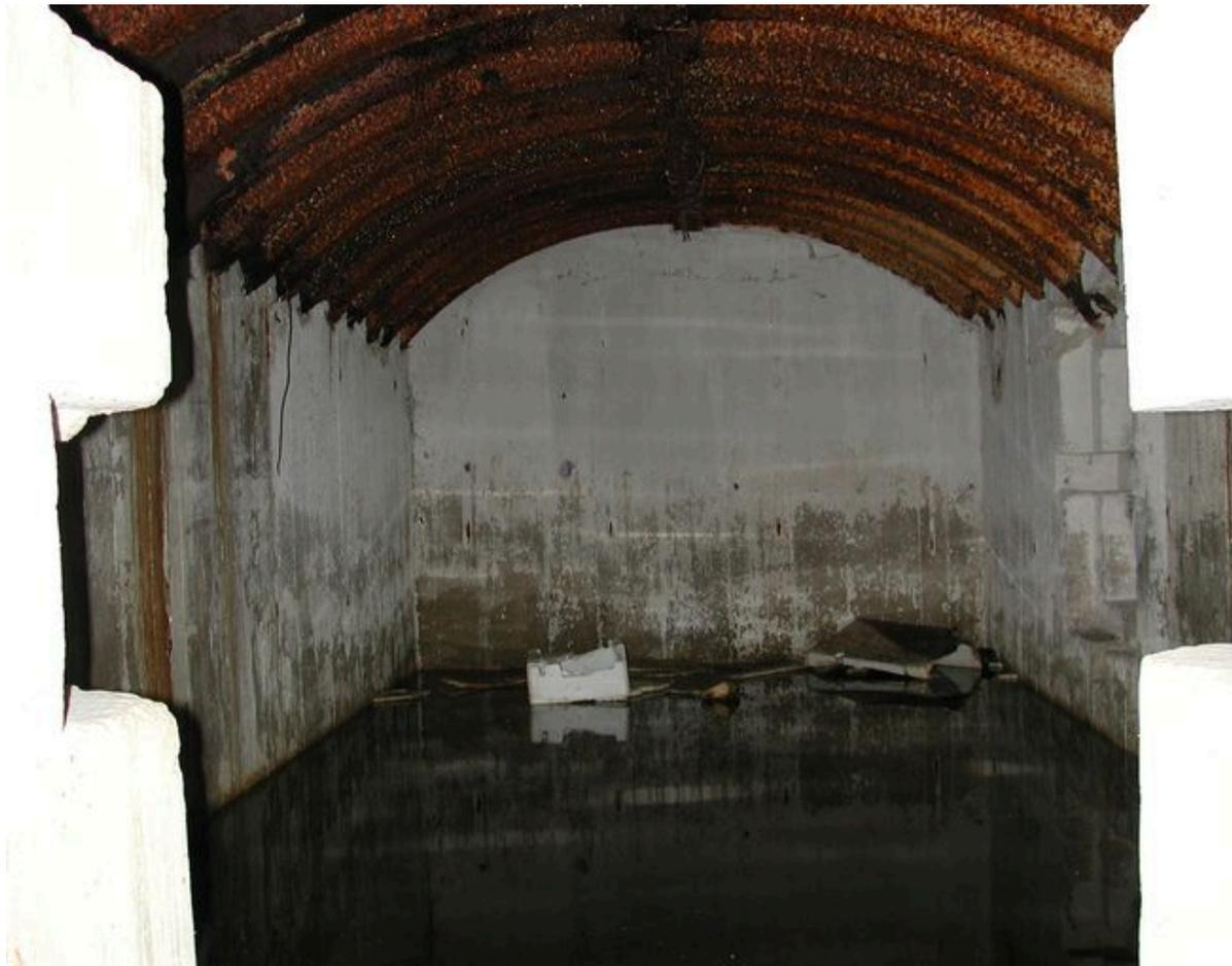
Vue de l'intérieur de l'abri type tôle métro (état en 2002). Le bunker est inondé
