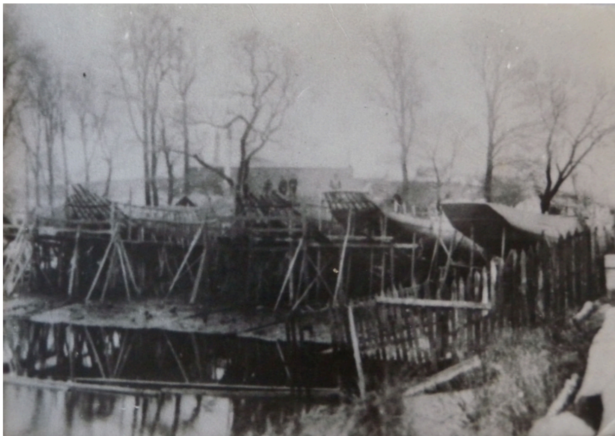
Vue des navires en construction, chantiers Bonne à Poulafret-Kérité, 1er quart 20ème siècle (collection particulière)
