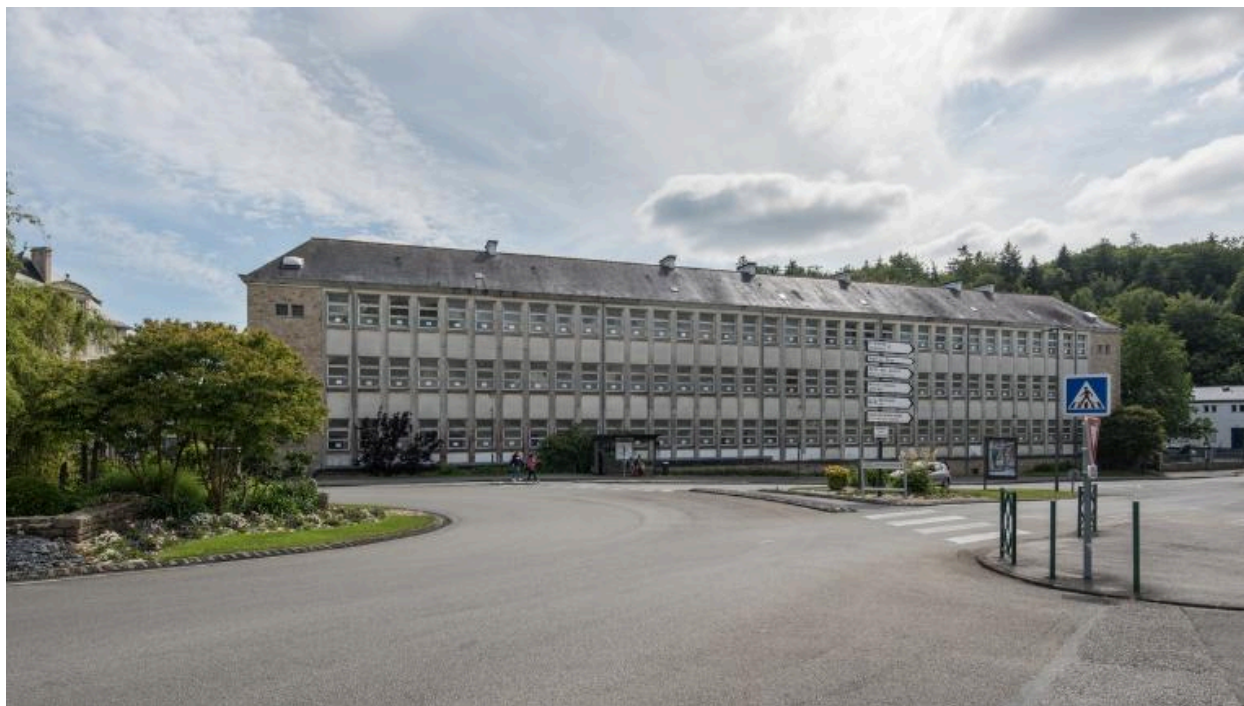
Externat, façade nord. Jacques Lachaud, architecte, 1962.
