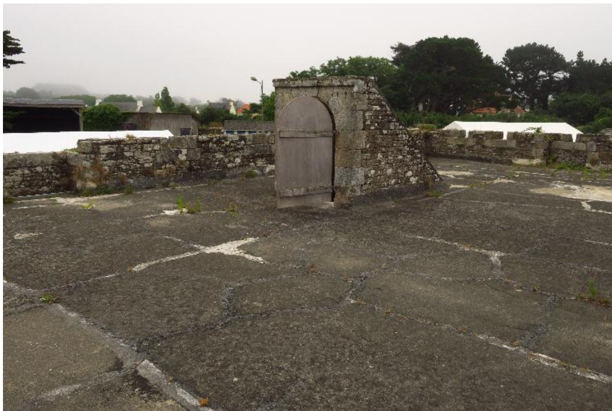
Groix, batterie du Gripp, corps de garde crénelé, terrasse.
