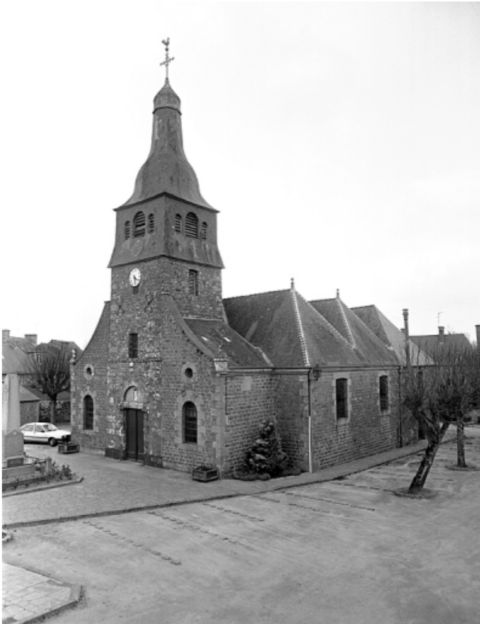
Elévation sud-ouest ; vue générale (état en 1994)
