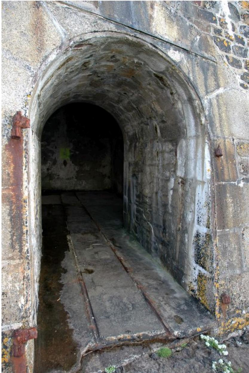
Vue de la batterie de Cornouaille : abri de projecteur (4e quart du 19e siècle) aménagée sous le mur de soutènement de la batterie (4e quart 17e siècle). A signaler : les rails pour le chariot du projecteur
