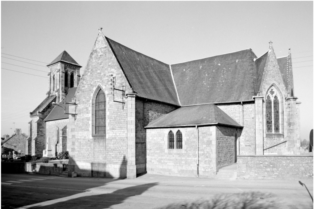
Elévation Sud-Est : vue générale
