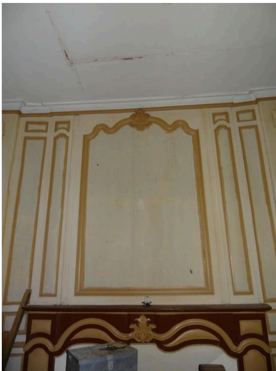
Boiseries de la pièce centrale du premier étage
