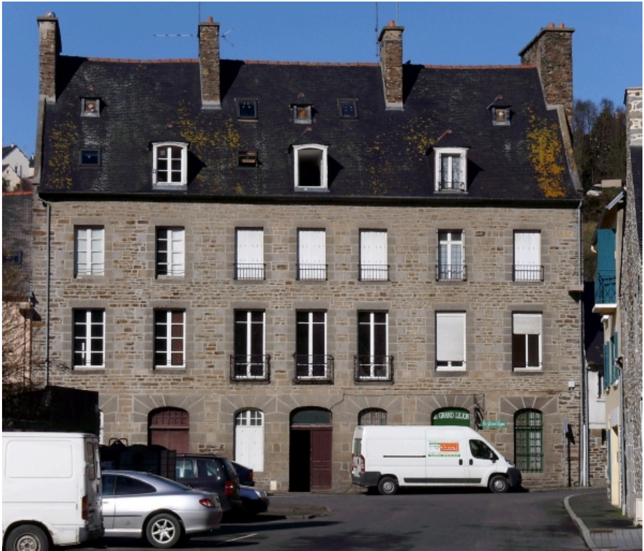
Vue générale de l'élévation principale (2008)
