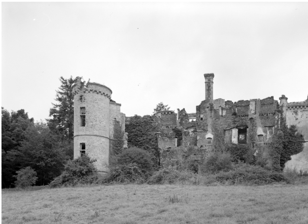
Château (vestiges), élévation sud-est.
