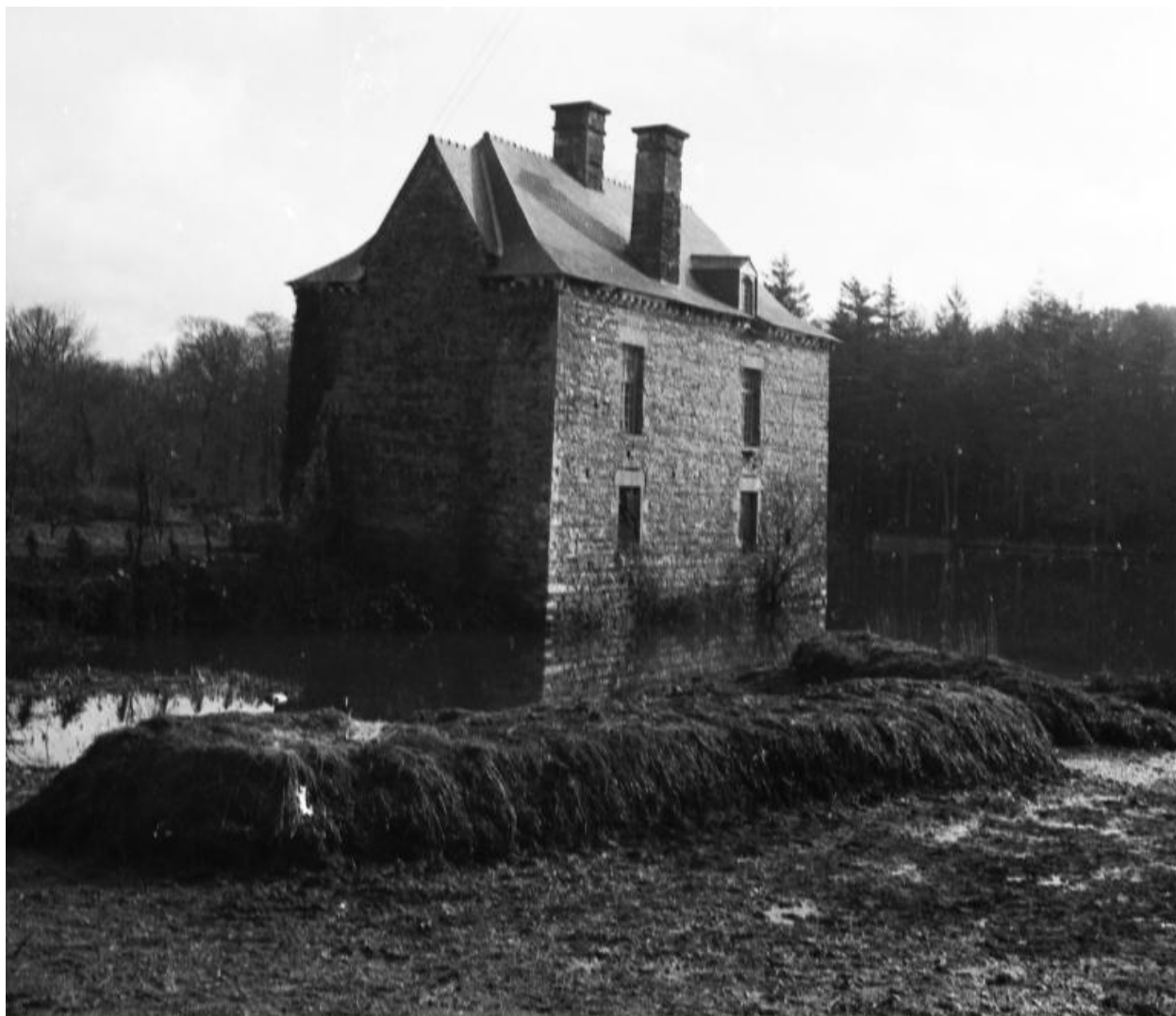
Vue générale prise du sud-ouest.
