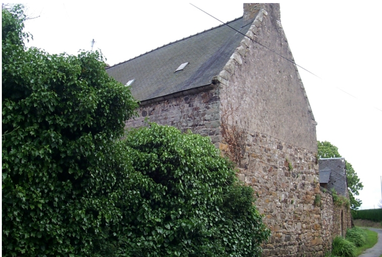
Vue générale (façade postérieure)
