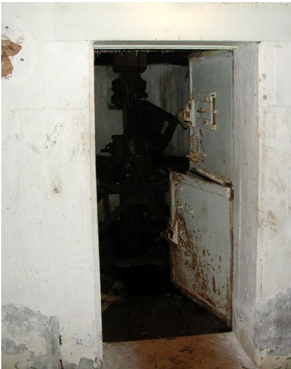
Vue intérieure : porte blindée à deux vantaux (état en 2003)
