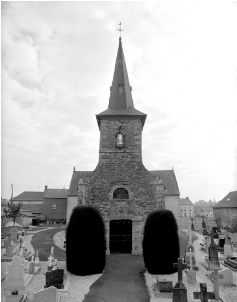
Vue générale ouest.
