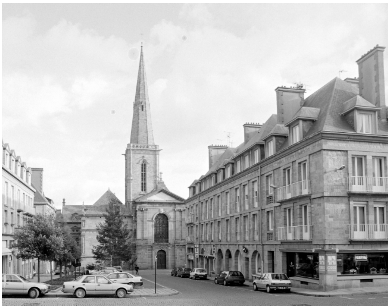
Elévation Ouest : vue générale
