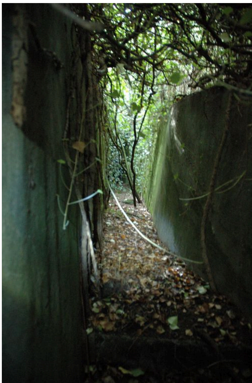
Vue d'un ensemble fortifié de la Presqu'île de Kermorvan constitué d'un Tobrouk pour mortier de 80 mm, tranchée bétonnée et abri
