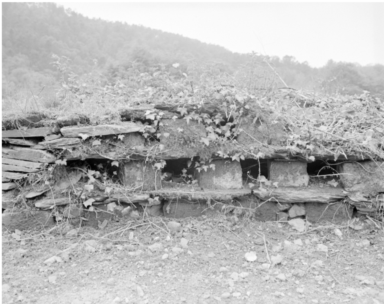
Colombier, détail : trous de boulins (état en 1977).
