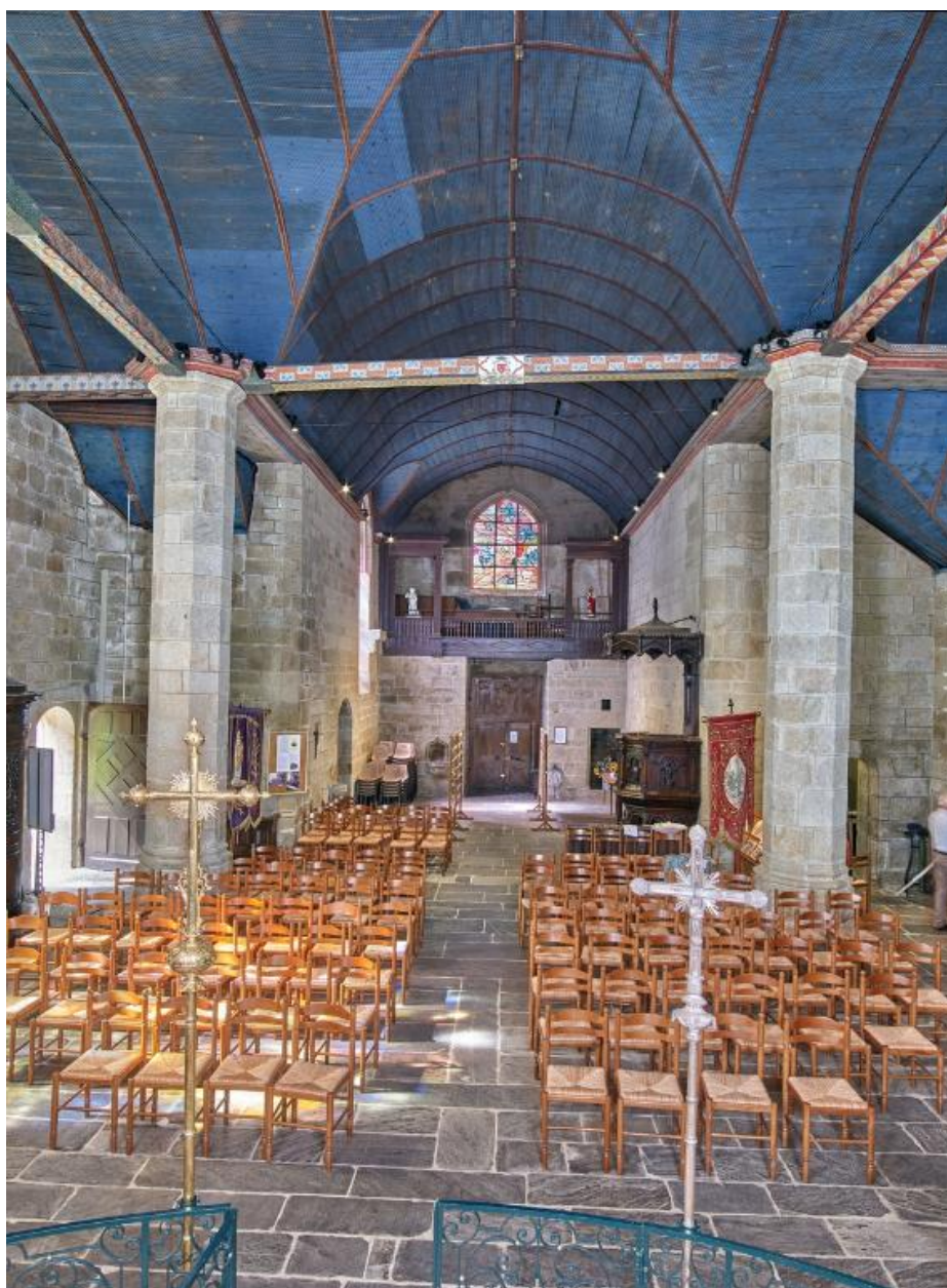
Vue depuis le chœur vers le fond de la nef
