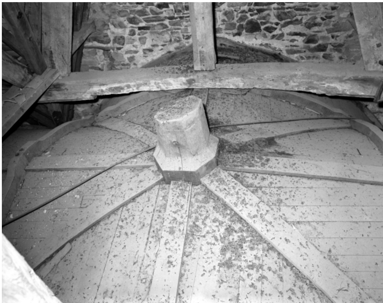
Bas-côté sud, extrados d'une fausse voûte.
