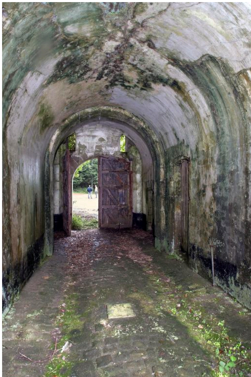
Brest : le fort de Penfeld, passage d'entrée, photographie réalisée le 13 mai 2009
