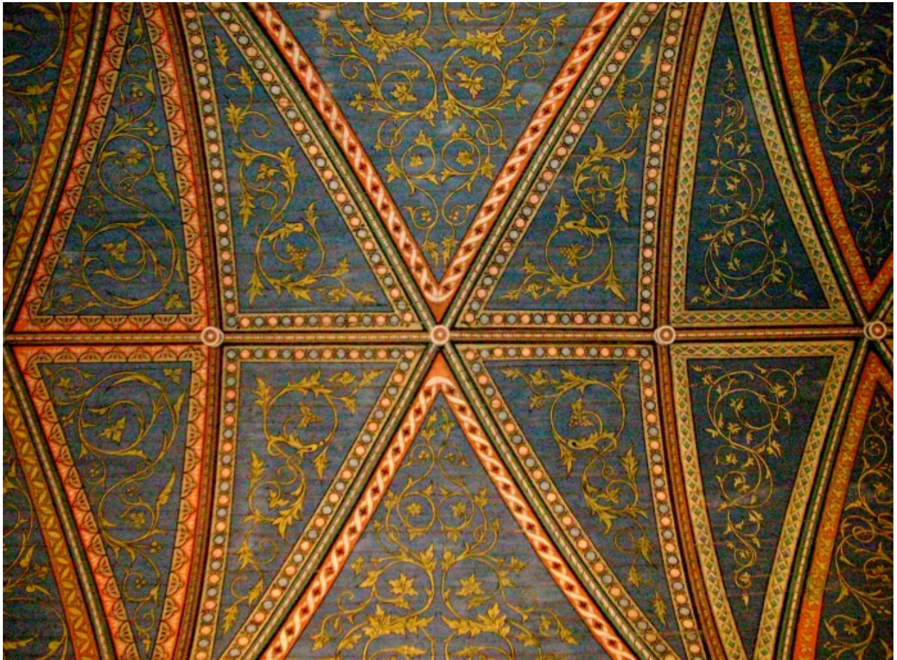
Plouigneau, église paroissiale Saint-Ignace : lambris de couverture dans la nef, détail
