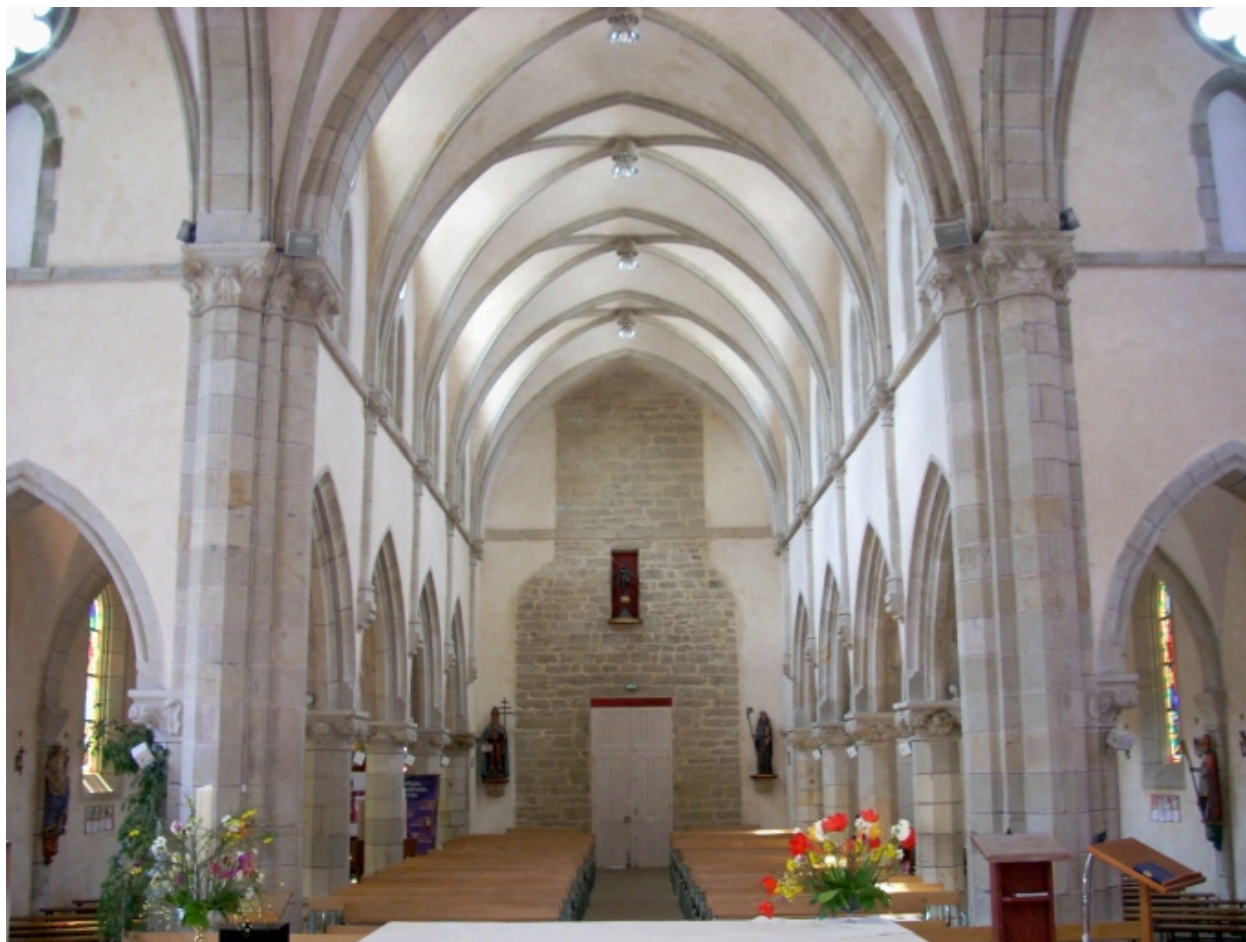
Coray, église paroissiale Saint-Pierre et Saint-Paul : vue axiale ouest
