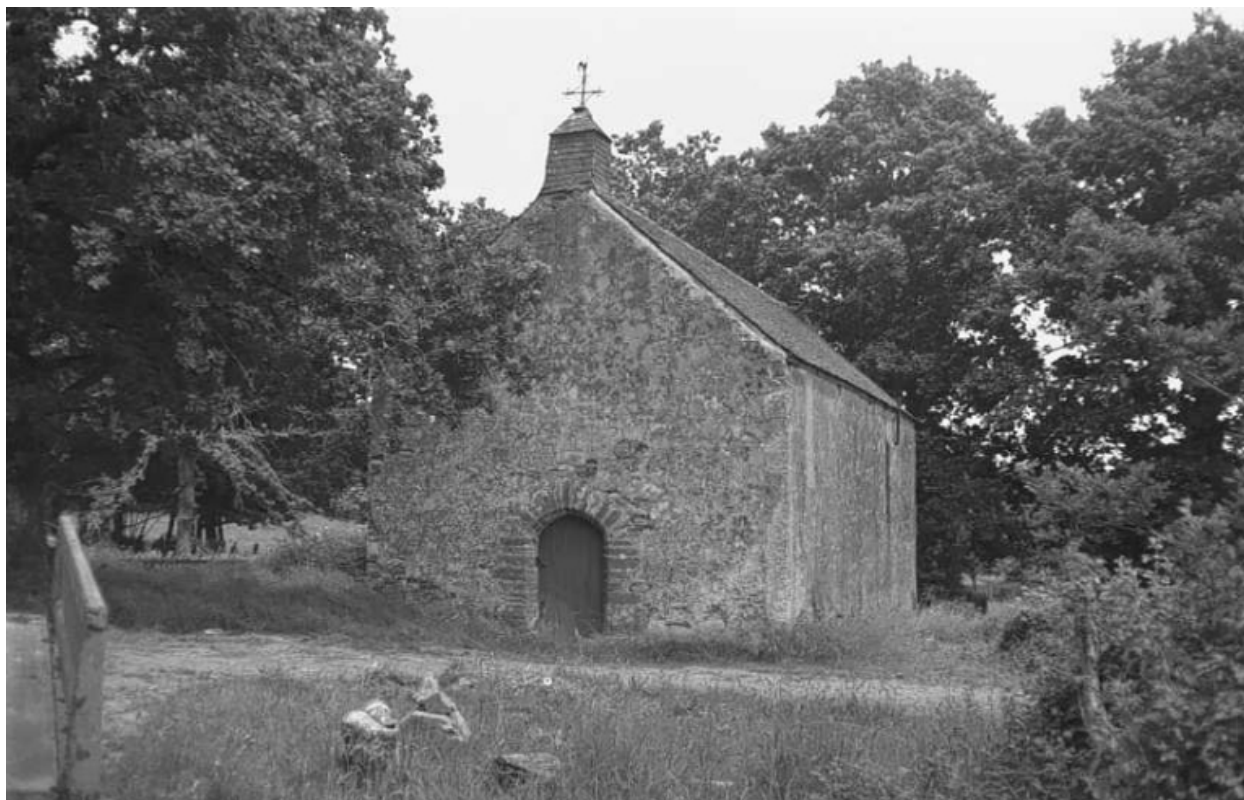
La chapelle en 1975 : vue générale ouest
