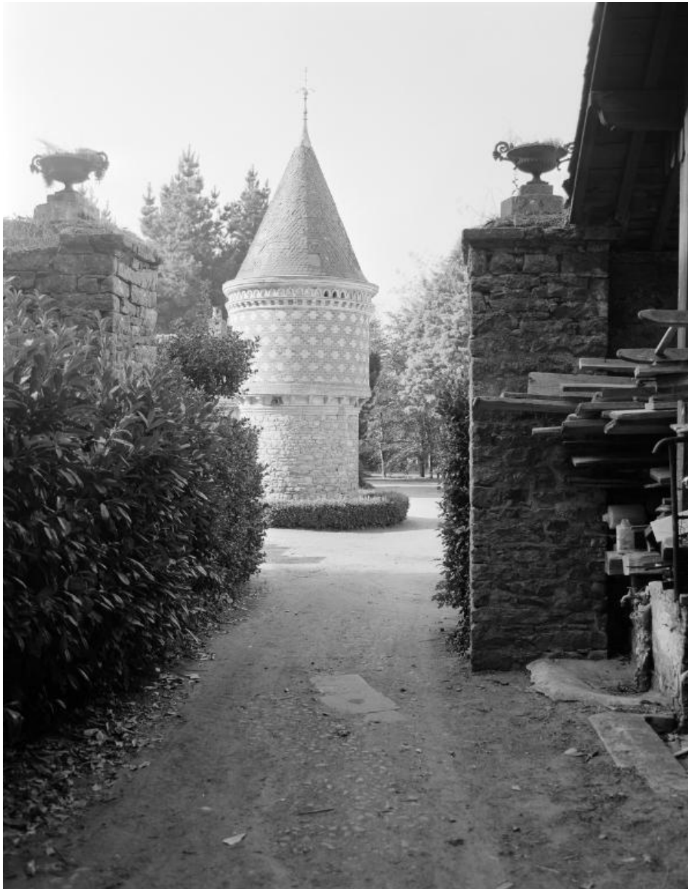
Ferme, piliers d'entrée et colombier.
