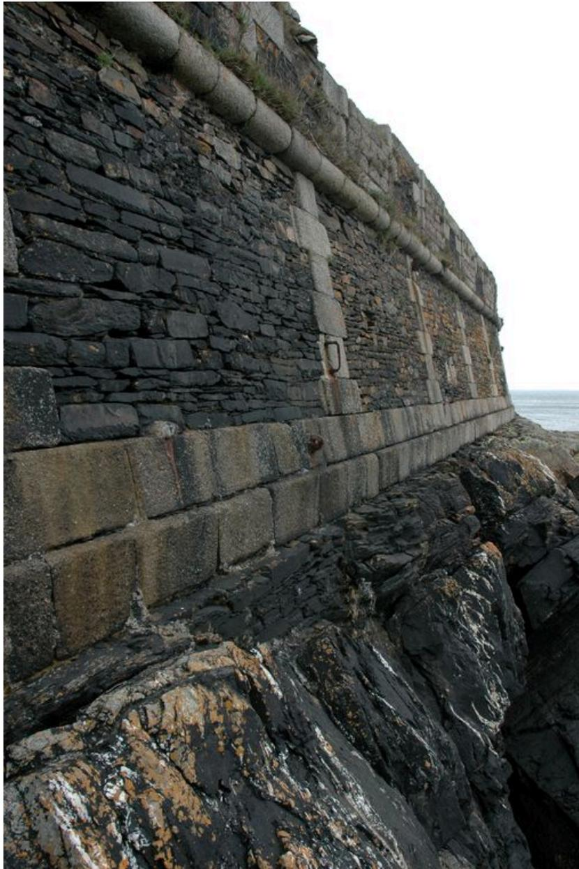
Vue de la batterie de Cornouaille : mur de soutènement de la batterie au niveau de l'abri de projecteur. Soubassement, chaînes, cordon, gargouilles et encadrement des créneaux en granite, remplissage en moellons de schiste
